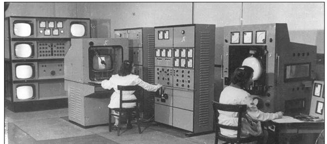
A TV-képcsővek mérőállomása a váci képcsőgyárban
