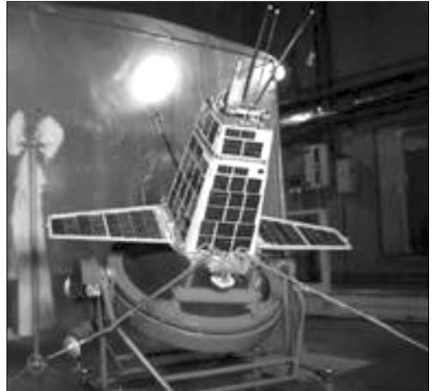
1. ábra A Kompas-2 a végső ellenőrzés alatt a hordozórakétára szerelés előtt
