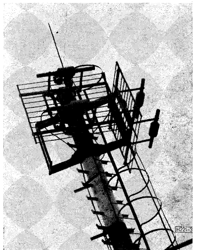
3. ábra. TV átjátszóállomás antennarendszere
