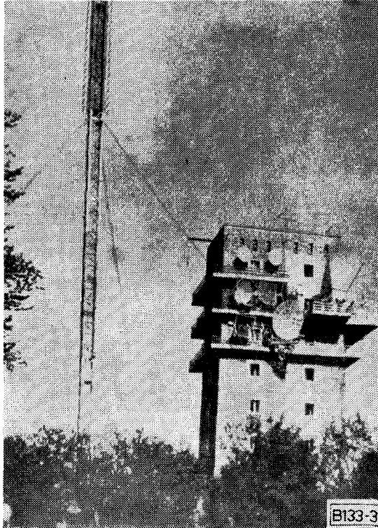
3. kép. Mikrohullámú antennák a hegytetőn álló épület tetején
