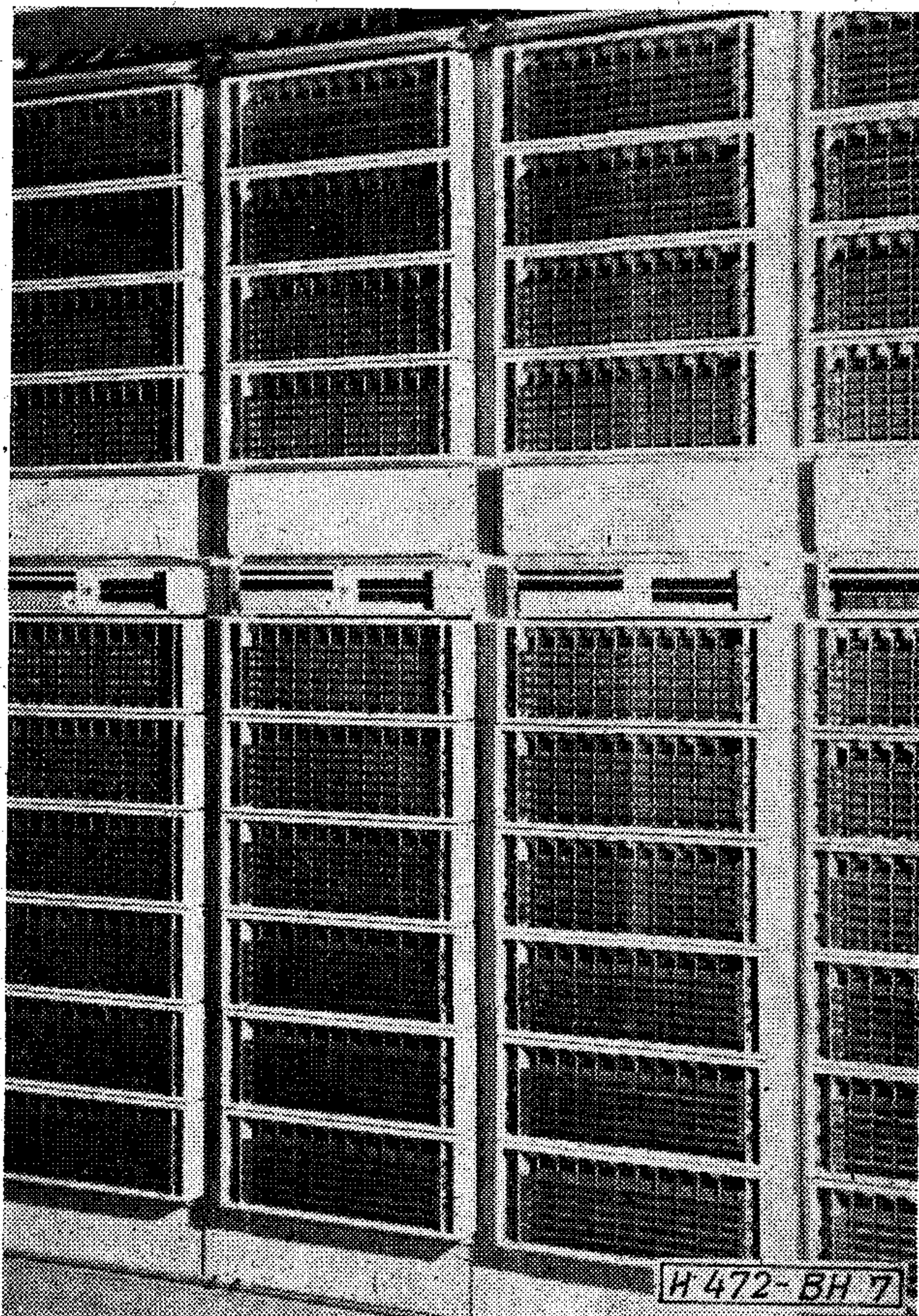
7. ábra. ARF-102 típusú városi főközpont kapcsoló keretei
